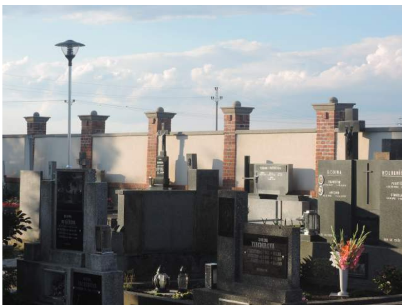
Opravena byla také vnitřní část hřbitovní zdi, instalováno bylo nové osvětlení
